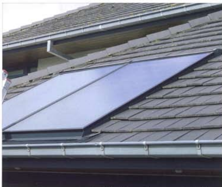
"Vroeger werden zonnepanelen op het dak geplaatst. Nu kunnen ze ook in het dak worden ingewerkt, en dan is dat niet storend, zeker niet in geval van een donker dak"
