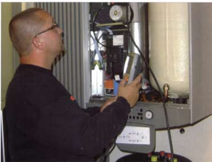
In de 63 cm brede mantel huist een tank-in-tankboiler van 62 liter uit inox. Als de zonneboiler afkoelt, wordt zo op de traditionele manier in warm water voorzien
